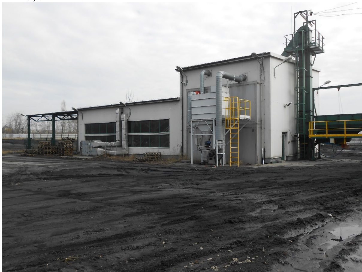
budynek lokalizacji linii ważąco - pakującej
