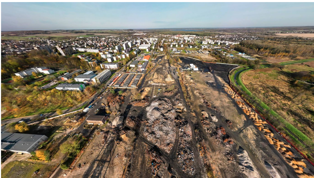
Ostatnie prace wyburzeniowe na planowanych do sprzedaży działkach pokopalnianych
