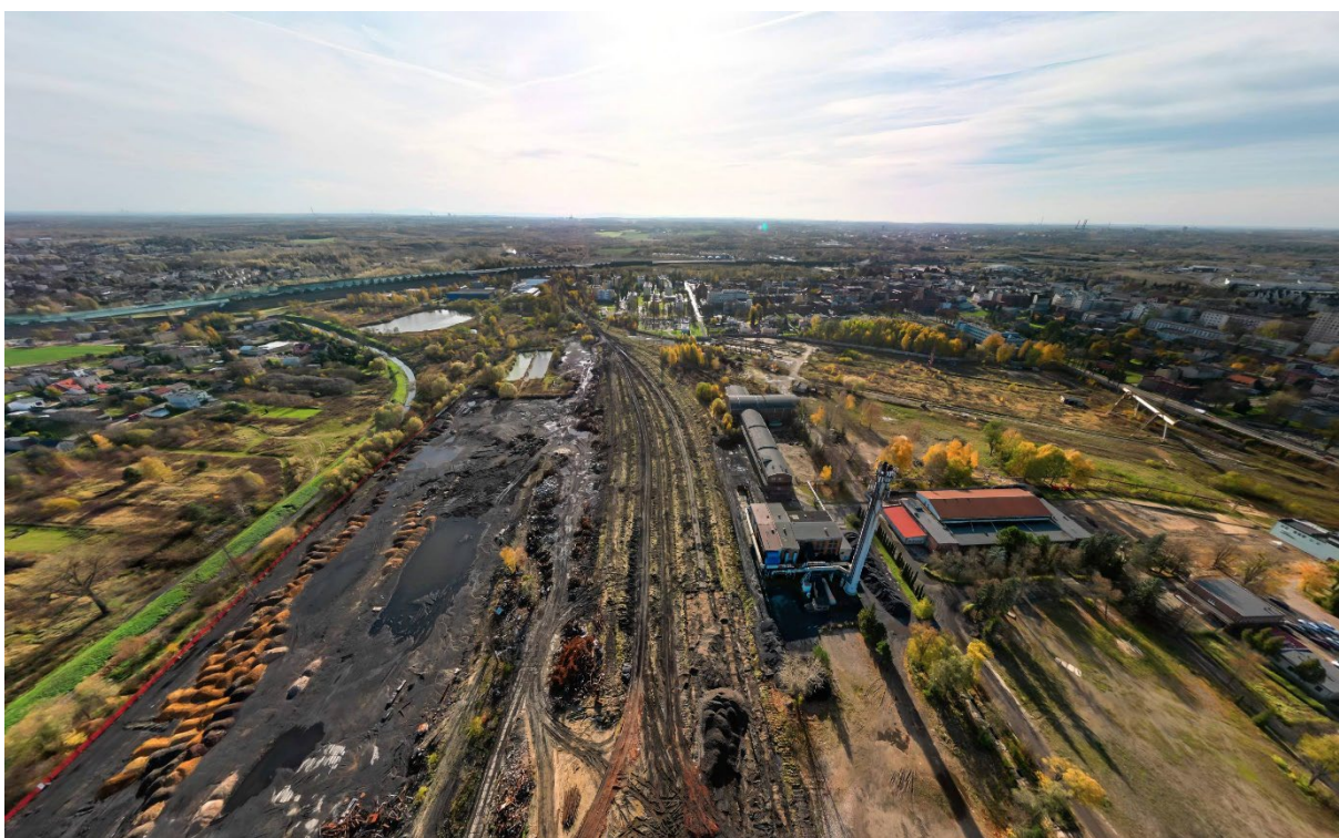
Południowa część działek od strony osiedla Sowińskiego
