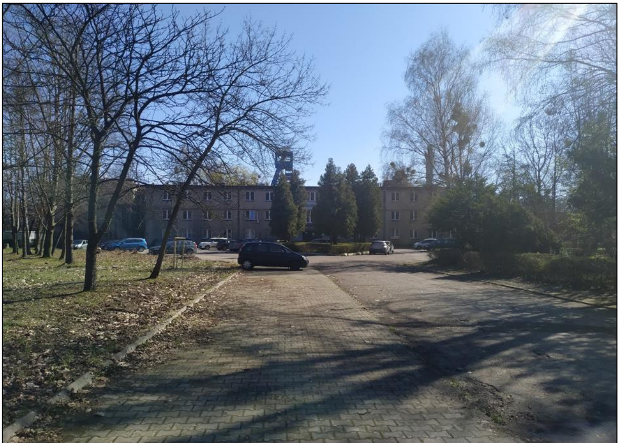
Strona zachodnia budynku od ulicy
