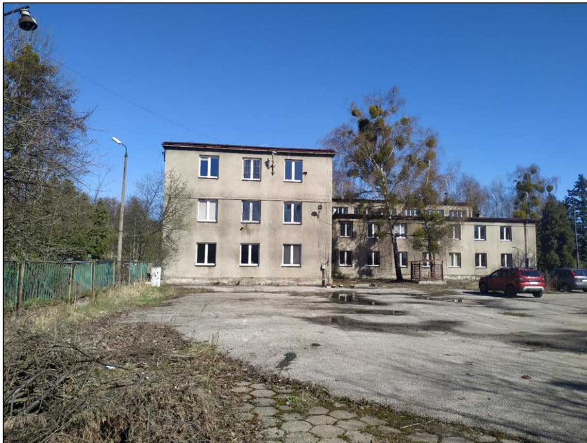
Widok budynku od strony południowej
