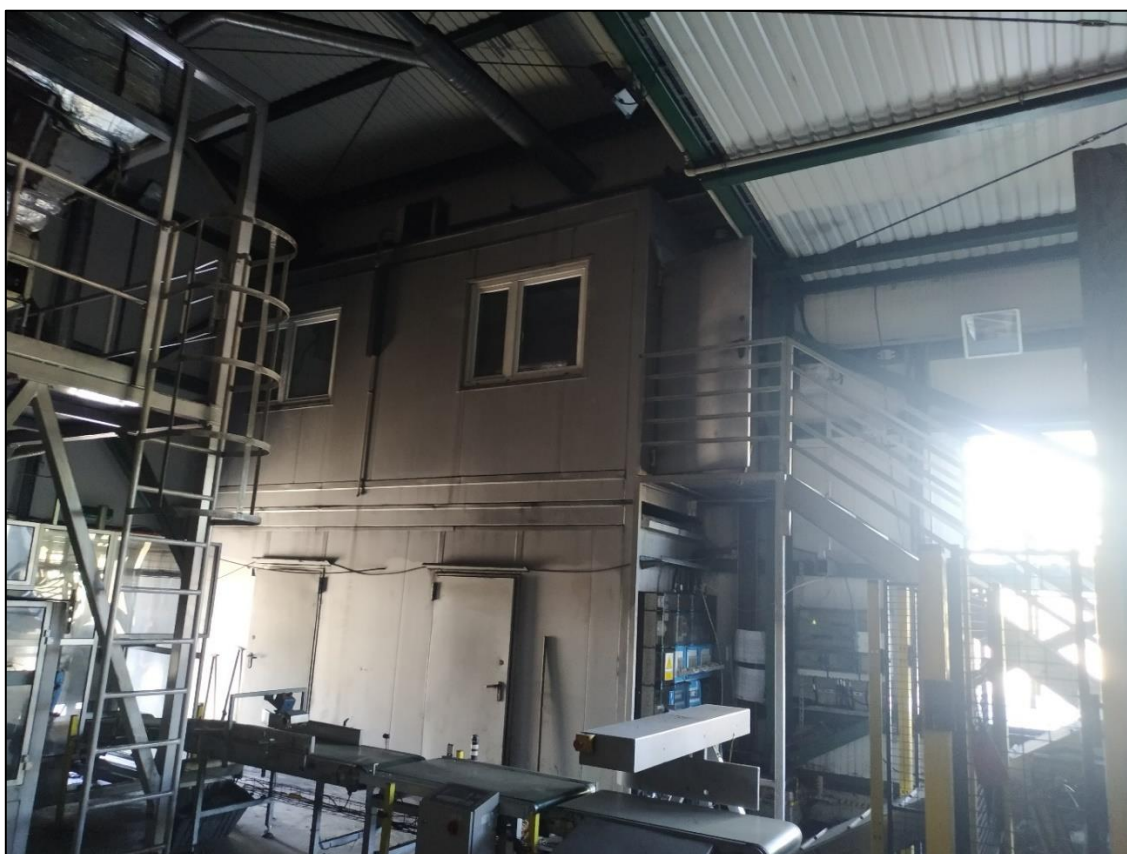
Kontenery ustawione jeden na drugim wkomponowane w budynek paczkowalni
