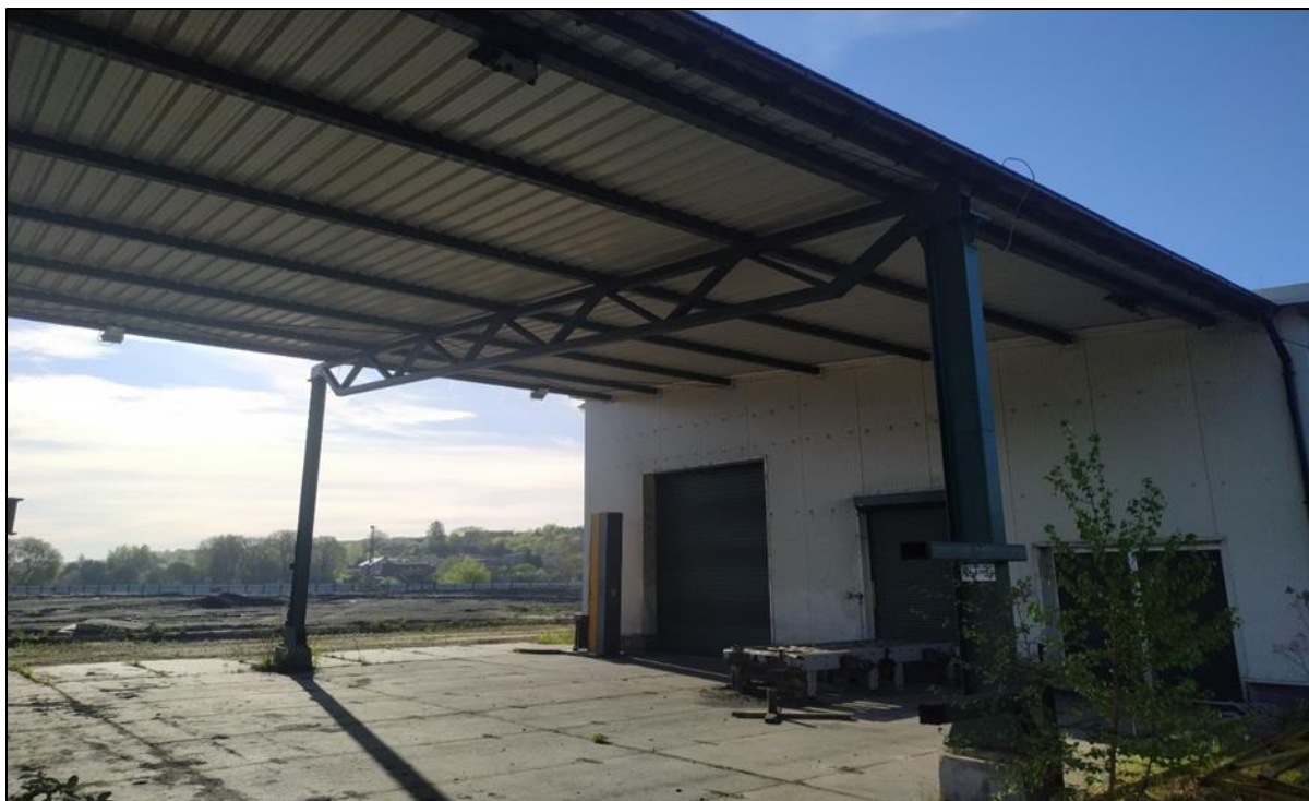
Konstrukcja wiaty stanowi przedłużenie budynku paczkowalni
