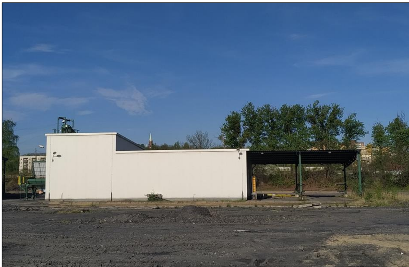
Budynek wraz z wiatą na składowany produkt
