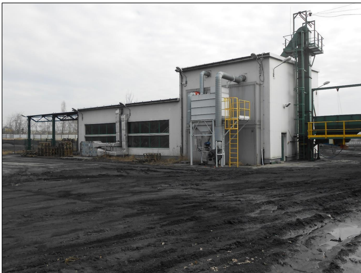
Budynek lokalizacji linii ważąco-pakującej
