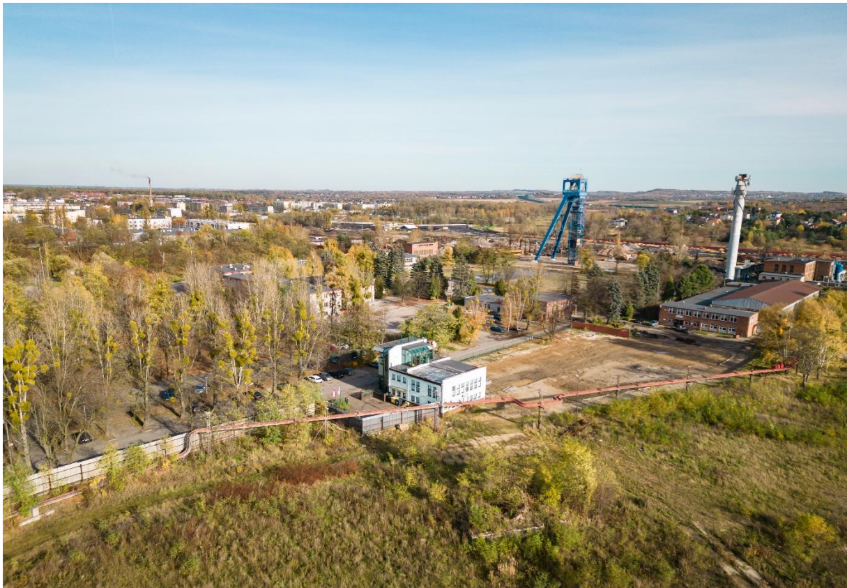
Budynek Zarządu i w tle Węglkokoks Kraj Serwis
