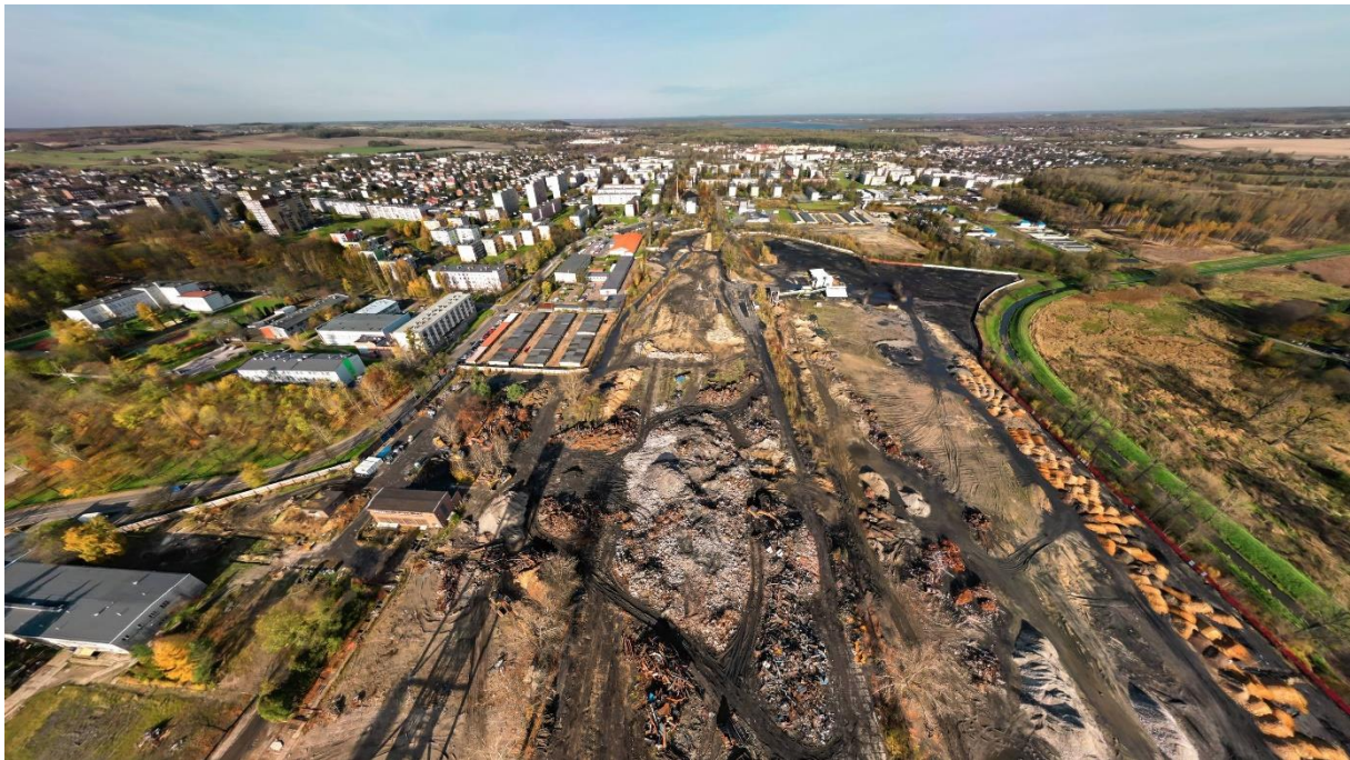
Widok nieruchomości od strony północnej bezpośrednio po wyburzeniach. Po prawej koryto rzeki Brynicy.
