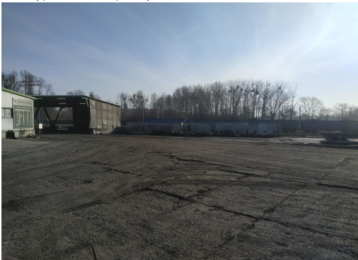
Miejsce lokalizacji przekładni – zdjęcie poglądowe
