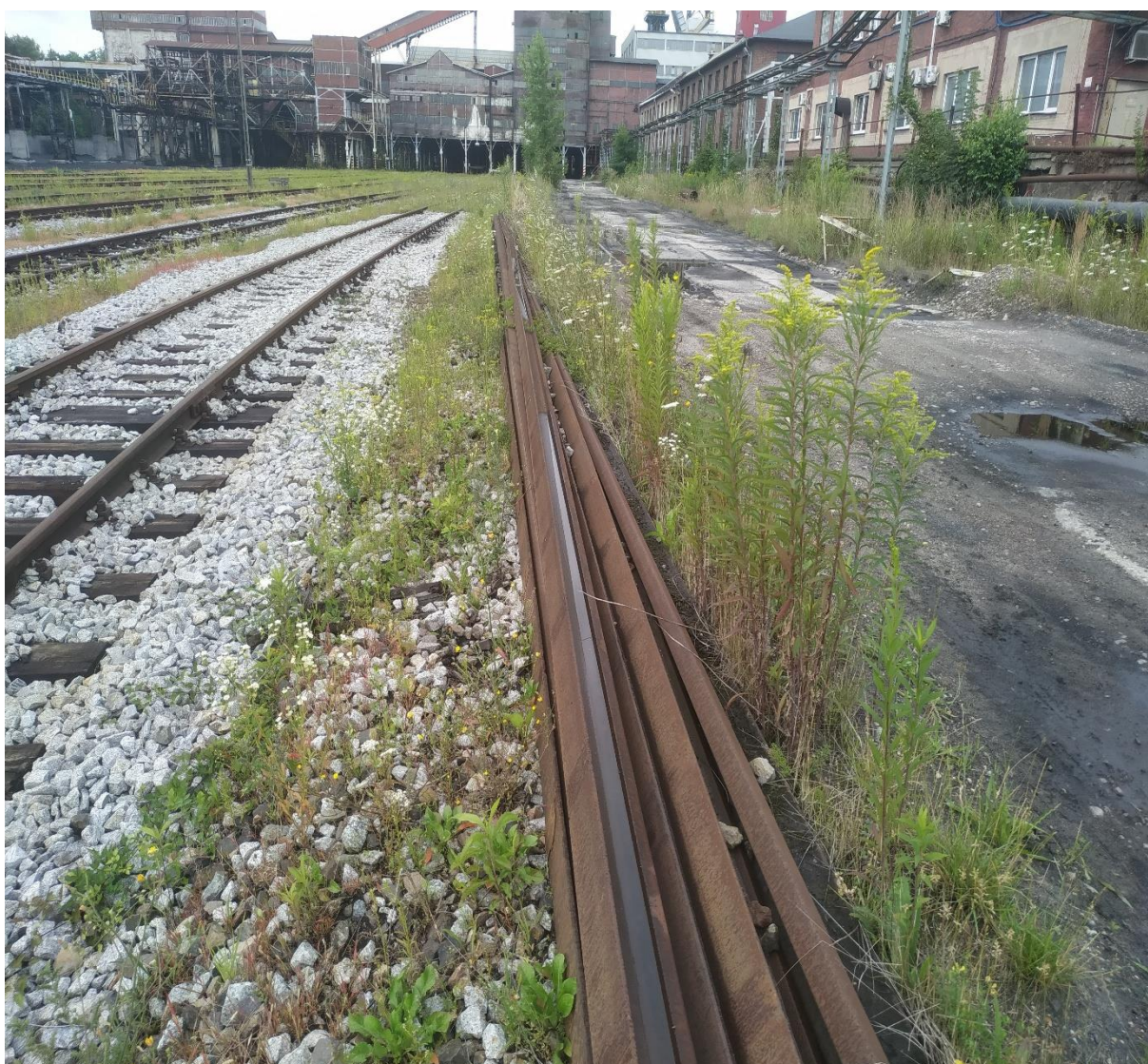
lokalizacja między drogą odstawy kamienia a skrajnym torem bocznicy kolejowej
