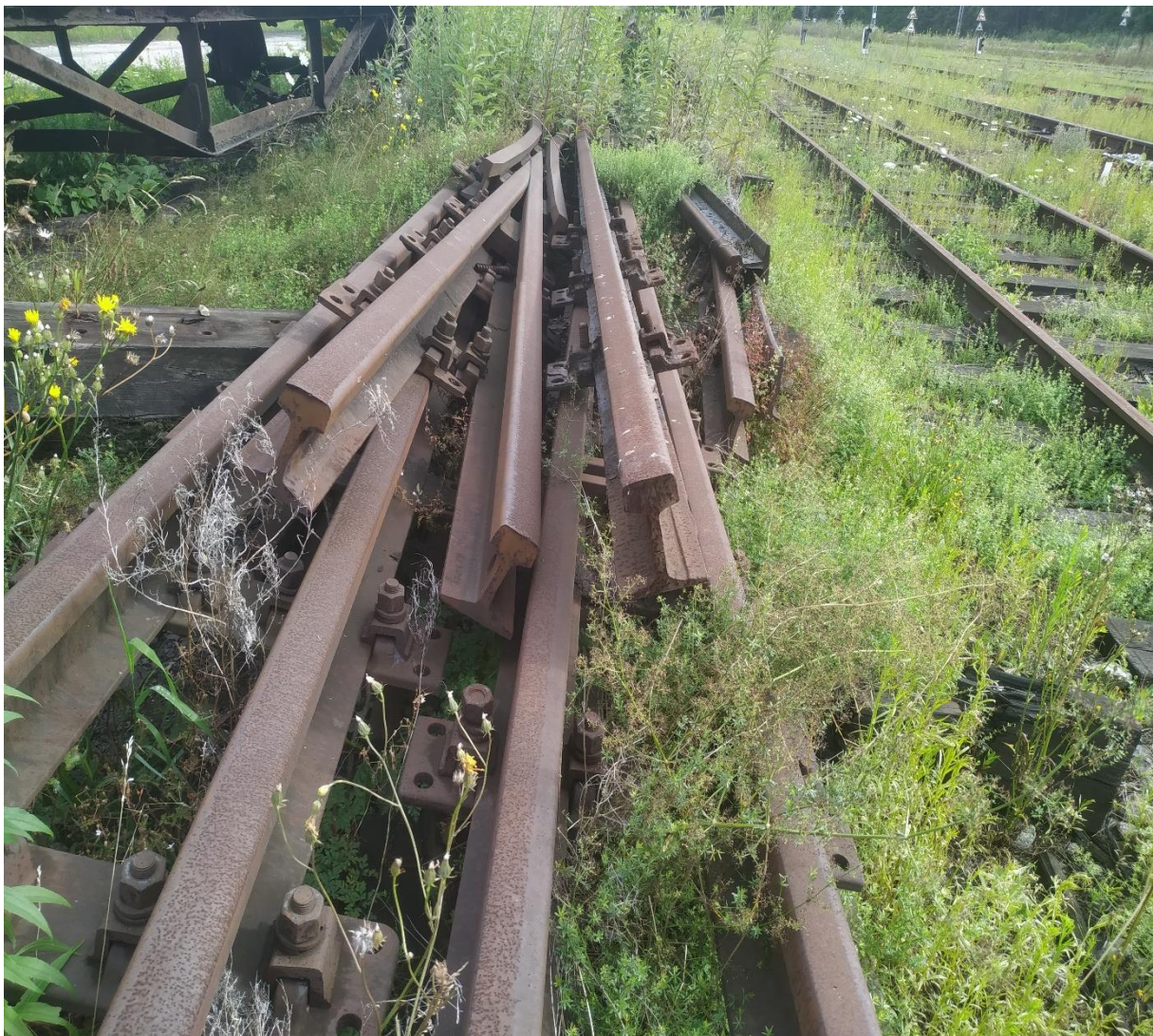
rozjazd kolejowy – stan aktualny
